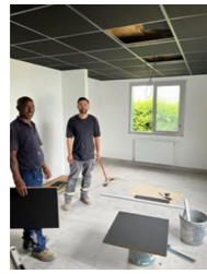
Pose du nouveau sous-plafond par Hamed et Zémeriam
