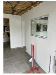
Pose des nouvelles fenêtres intérieures
