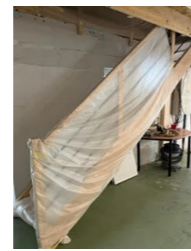
L'escalier accédant à la mezzanine
